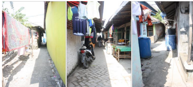
Gambar 1.b. Kondisi Jalan gang di Pulau Panggang
