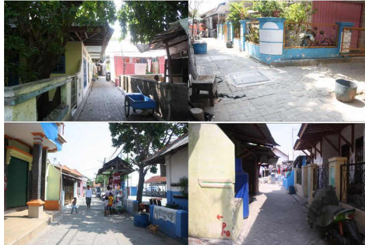
Gambar 1.a. Kondisi Jalan Utama di Pulau Panggang
