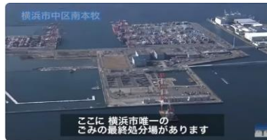
Gambar 13. Dermaga pabrik pembakaran sampah.
