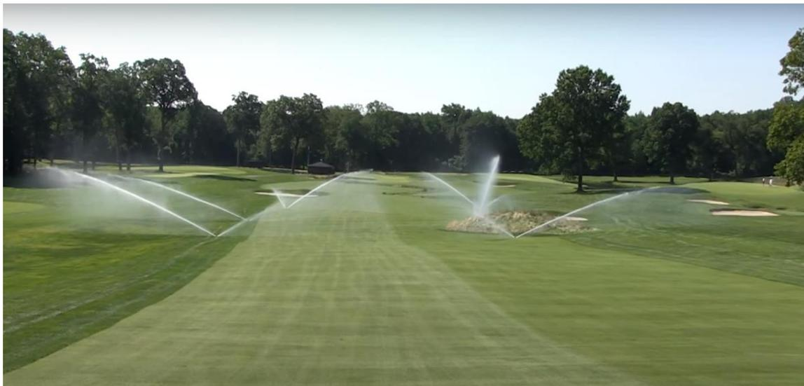
Gambar 5 Alat penyiraman otomatis pada lapangan golf
