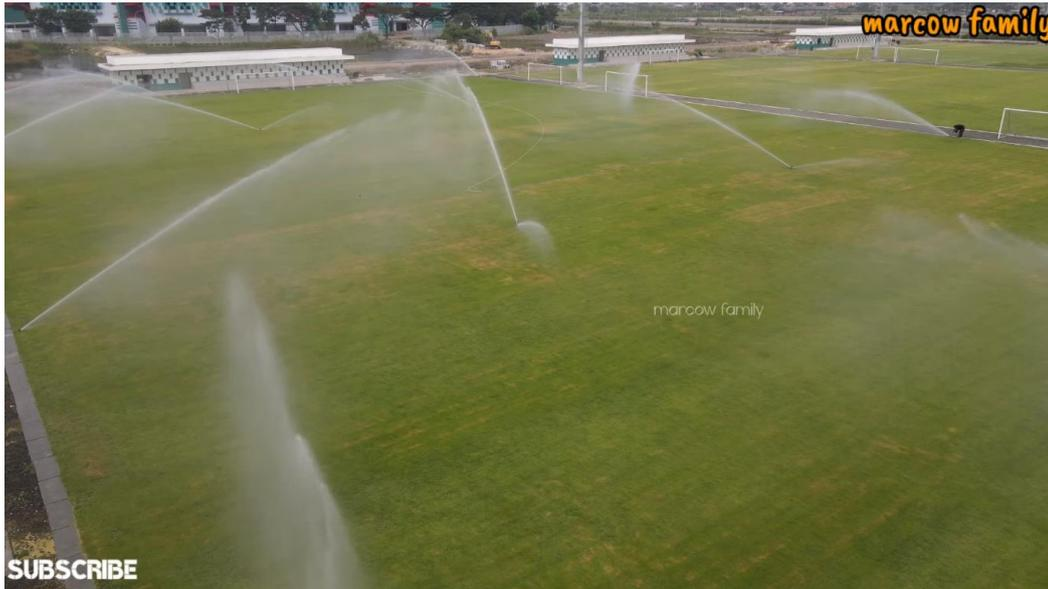
Gambar 4 Alat penyiraman air otomatis pada lapangan stadion Bung Tomo
