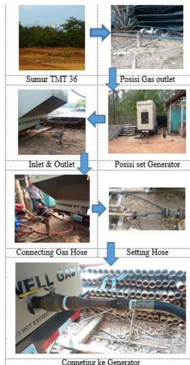
Gambar 5 Urutan Pemasangan Pipa ke Generator
