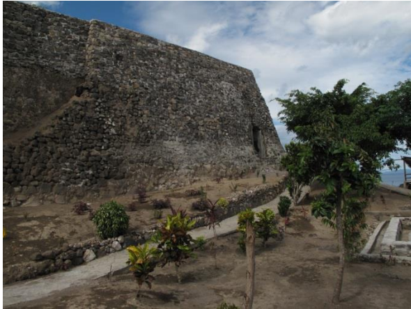
Ruang tempat menyimpan mesiu setelah restorasi 2013
