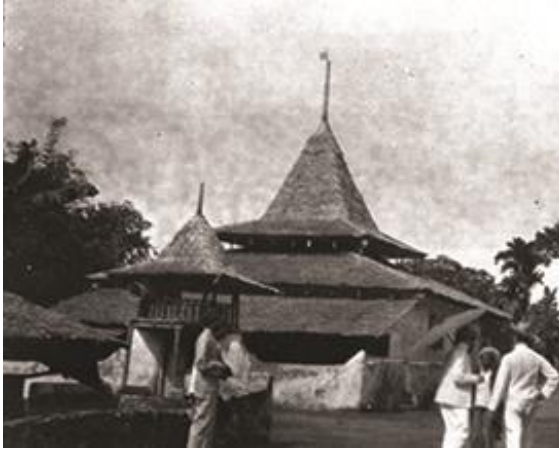
Bentuk atap pada awal abad 20. Atap jurai 2 tumpuk ditambah teritisan dengan bahan penutup atap rumbia, kemiringan atap curam, pada atap bagian atas tidak terdapat bukaan.
