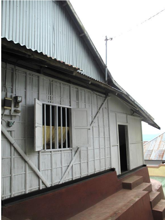
Dinding bambu pada rumah Sowohi, diberi perkuatan berupa dua bilah bambu yang diletakkan secara diagonal.
