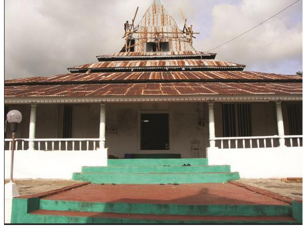
Bentuk atap sebelum pemugaran 2006-2010. Atap jurai 3 tumpuk ditambah teritisan dengan bahan penutup atap seng, kemiringan atap tengah dan bawah landai, terdapat bukaan pada atap bagian atas.
